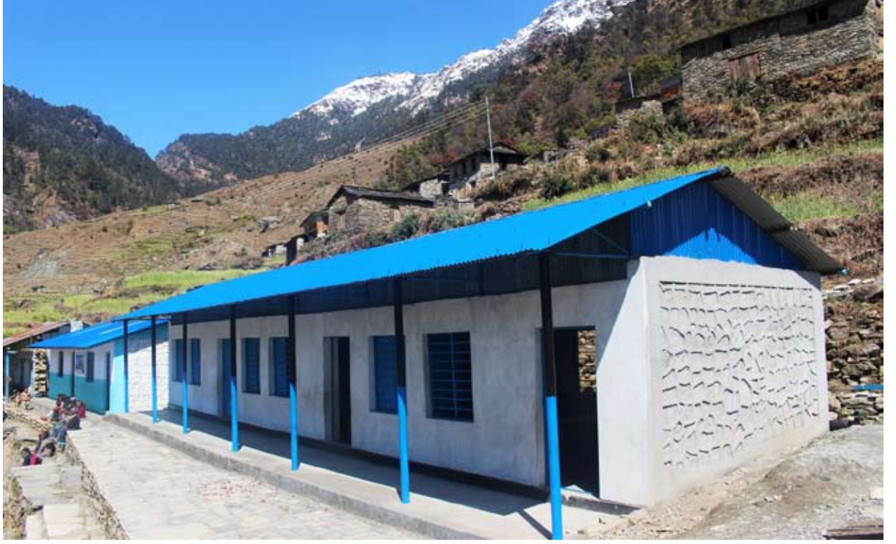
कक्षाकोठा भवन : रघुगंगा गाउँपालिकाको ठाडाखानी स्थित मालिका आधारभूत विद्यालयमा निर्माण भएको कक्षा कोठा भवन । जिल्ला शिक्षा र अमेरीकाको जिएनआई संस्थाको सहयोगमा ५ वटा कोठा भएको दुई वटा भवन निर्माण भएको विद्यालयमा थप ५ वटा कोठा भएको भवन आवश्यक छ ।
