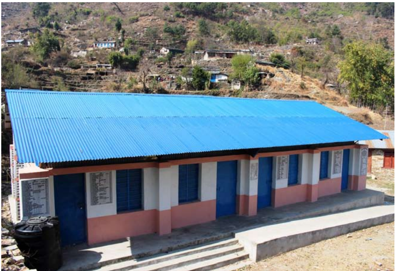
विद्यालय भवन : म्याग्दीको भुर्ङ तातोपानीको मान्देढुङ्गामा रहेको हिमालयन प्राबीमा निर्माण भएको दुई कोठे भुक्म्प प्रतिरोधी क्षमताको कक्षा कोठा भवन ।
