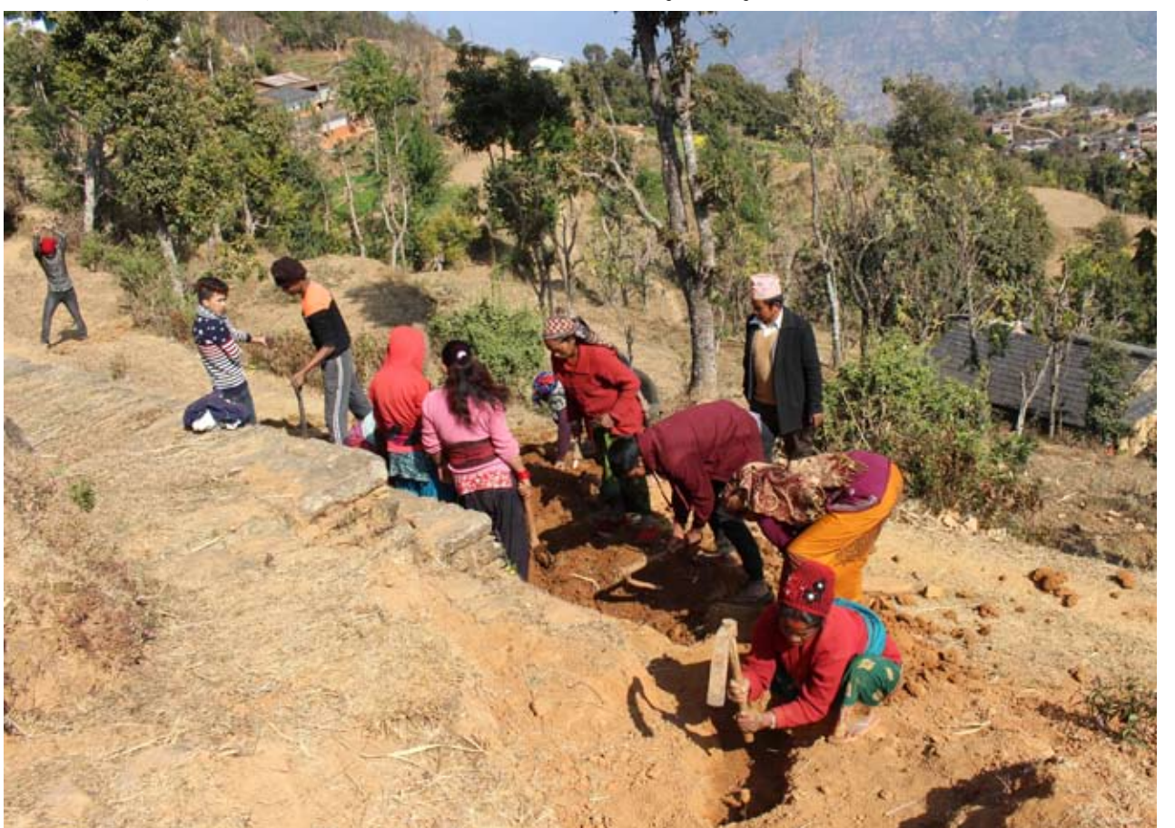
श्रमदान : बेनी नगरपालिका ३ भकुण्डेका बासिन्दा ज्यामरुककोट, अर्जम रत्नेचौर खानेपानी तथा सरसफाई आयोजनाको पाईपलाईन खन्न श्रमदान गर्दै ।
