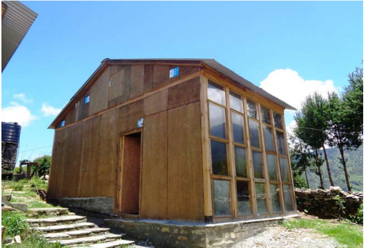
नमुना घर : दक्षिण कोरियाको प्रविधि अनुसार म्याग्दीको पर्यटकीय गाउँ नागीमा निर्माण भएको वातावरण अनुकूलित भुकम्प प्रतिरोधी क्षमताको नमुना पाहुना घर । तस्विर : सन्तोष गौतम/नवविकल्प
