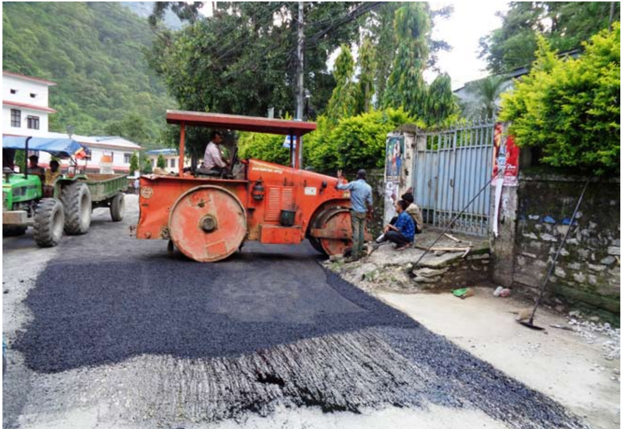
सडक मर्मत : बेनीको जिल्ला प्रशासन कार्यालय अगाडि रहेको सडकमा कालोपत्रे गरिँदै । तस्विर नवविकल्प
