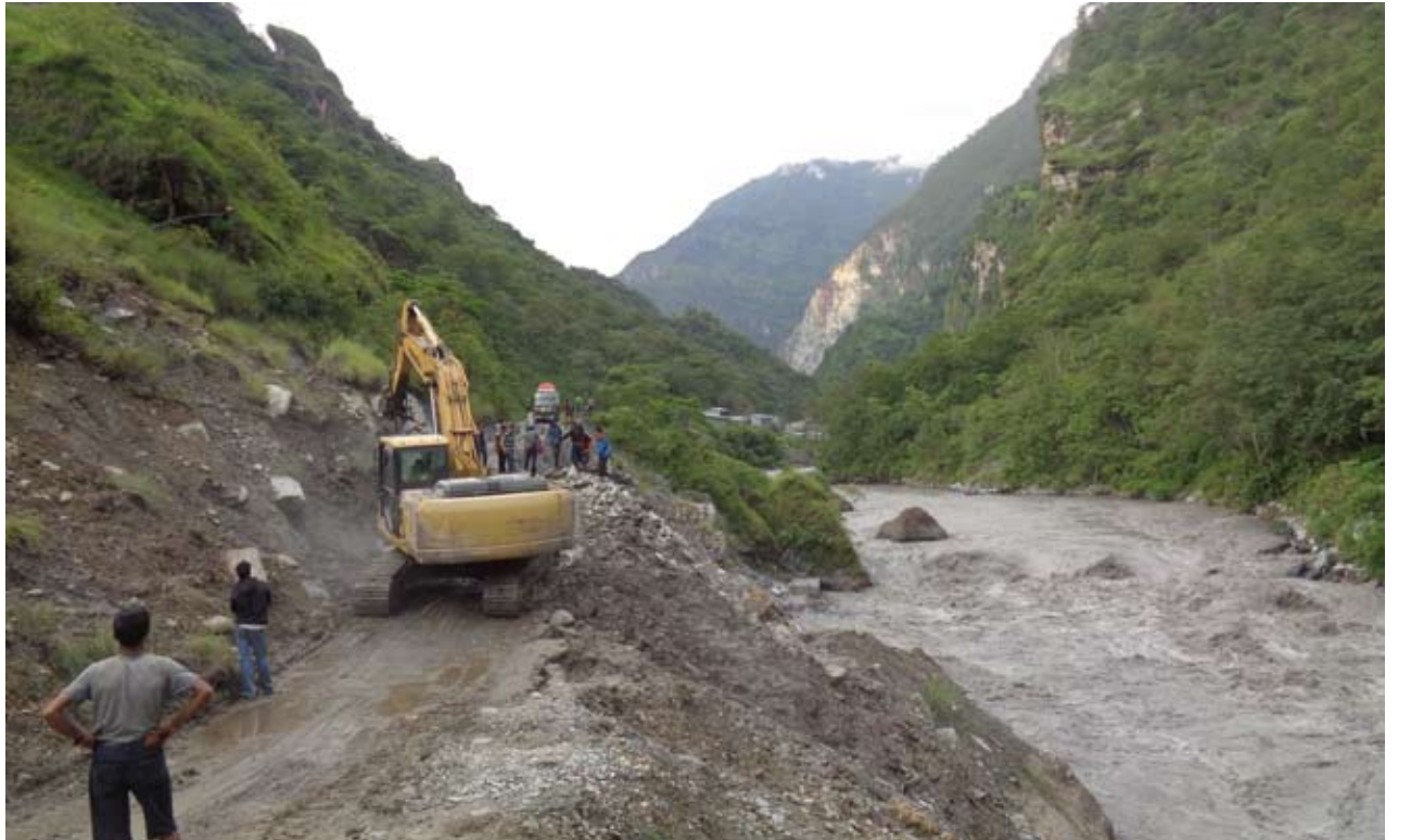
बाटो मर्मत : लगातारको वर्षाले बेनी-मुस्ताङ सडक बिग्रिएर सिधा यातायात सञ्चालन हुन नसक्ने भएपछि सो बाटो मर्मत गरिँदै छ । तस्वीर : नवविकल्प
