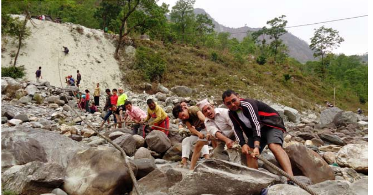
बल गरौं साथीहरू : कालीगण्डकी नदी माथी भोल्डुङ्गे पुल निर्माणका लागि लठो तान्दै म्याग्दीको बेनी नगरपालिका १ आनन्दनगरका वासिन्दाहरू ।
