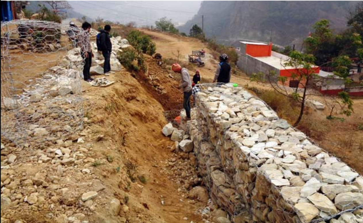
डिलासुस्तीको नमुना : एडिबीको सहयोगमा जिबिस मार्फत सञ्चालित विकेन्द्रित ग्रामीण पुर्वाधार निर्माण तथा जीविकोपार्जन सुधार कार्यक्रम (डिलीप) अन्तरगत बेनी देउराली सडकको महारानी खण्डमा ग्याविन पखाल लगाइदै । फाइल तस्वीर
