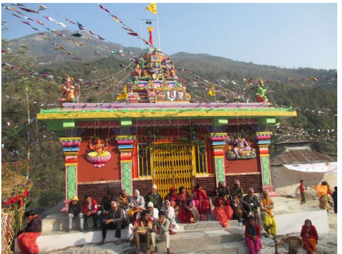
मन्दिर निर्माण: बेनी नगरपालिका-५, स्थित गलेश्वरधाममा करिब ६० लाखको लगानीमा पुनर्निर्माण गरिएको राधाकृष्णमन्दिर । तस्वीर: प्रताप बानियाँ
